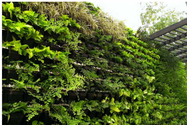
Tường xanh tại Hoa Sữa Villa - Vinhomes Riverside - Hà Nội.
