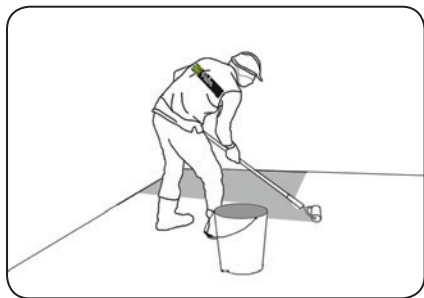
1 Thi công lớp chống thấm
